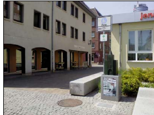
Eingangsbereich ungenügend gestaltet
