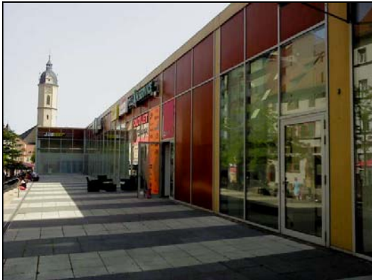
Neue Mitte auf der Nordseite – mangelhaftes Eingehen auf die Johannisstraße
