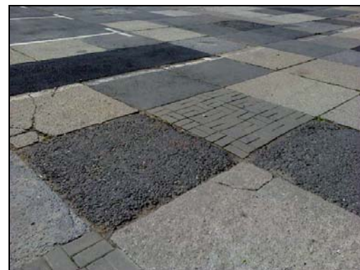
Provisorische Befestigung ausgedehnter Teile des Eichplatzareals
