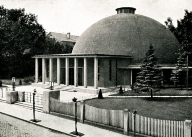
Das Jenaer Planetarium, errichtet in Zeiss-DYWIDAG-Schalenbauweise, ca. 1928
