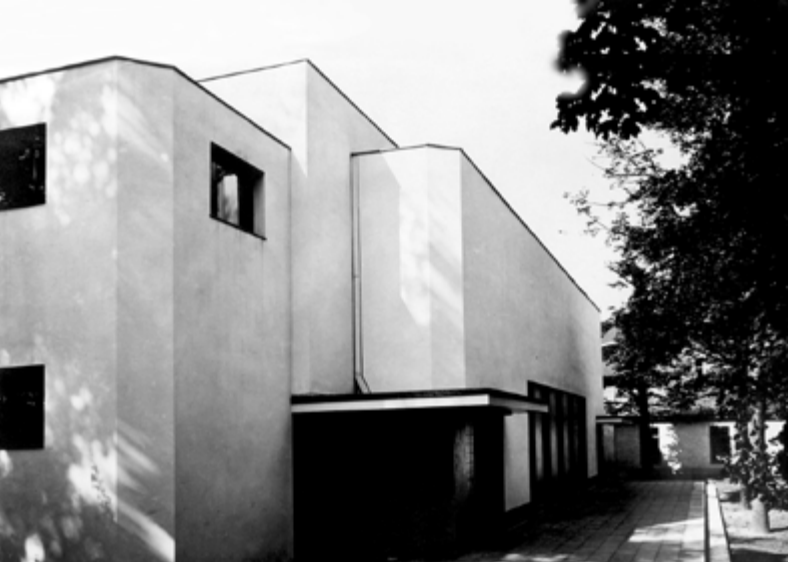
Fassade des Stadttheaters nach der Neugestaltung durch Walter Gropius, 1922
